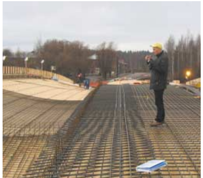
Sillan arkkitehtisuunnittelusta vastaava arkkitehti Mikko Kaira toteaa siltakannen raudoitustyön edistyvän hyvää vauhtia.
