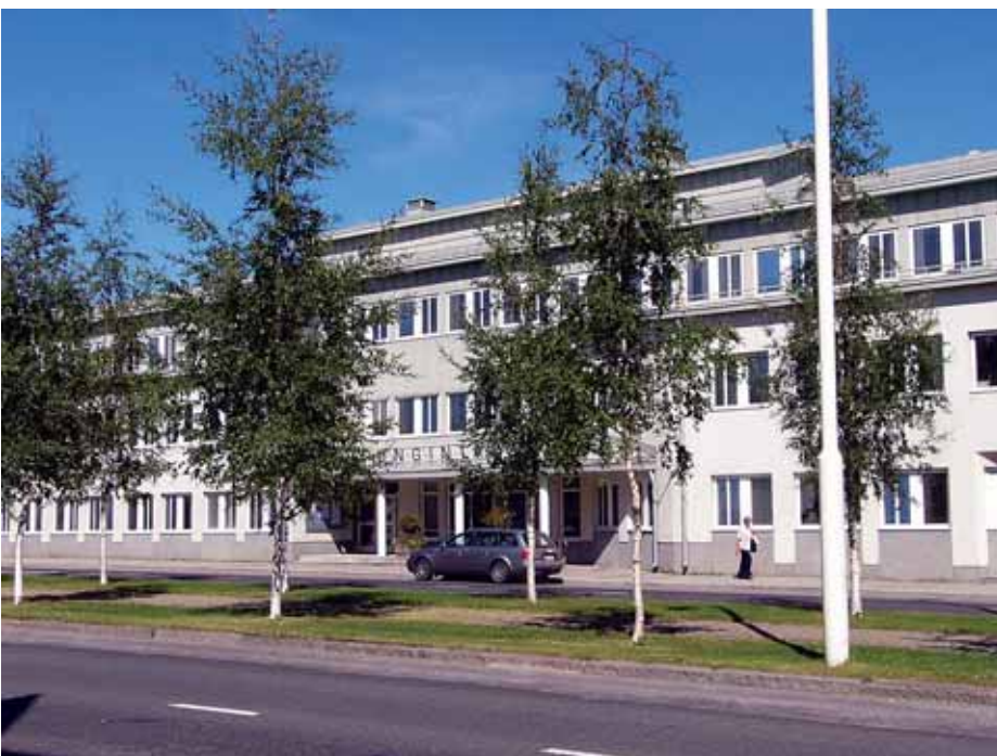
Kuntien sisäinen käyttö tapahtuu Intranetin kautta, josta käyttäjät löytävät muun muassa kartta-aineistoja, rekisteritietoja, johtotietoja ja dokumenttienhallinnan tietoja. Kuvassa Iisalmen kaupungintalo.
